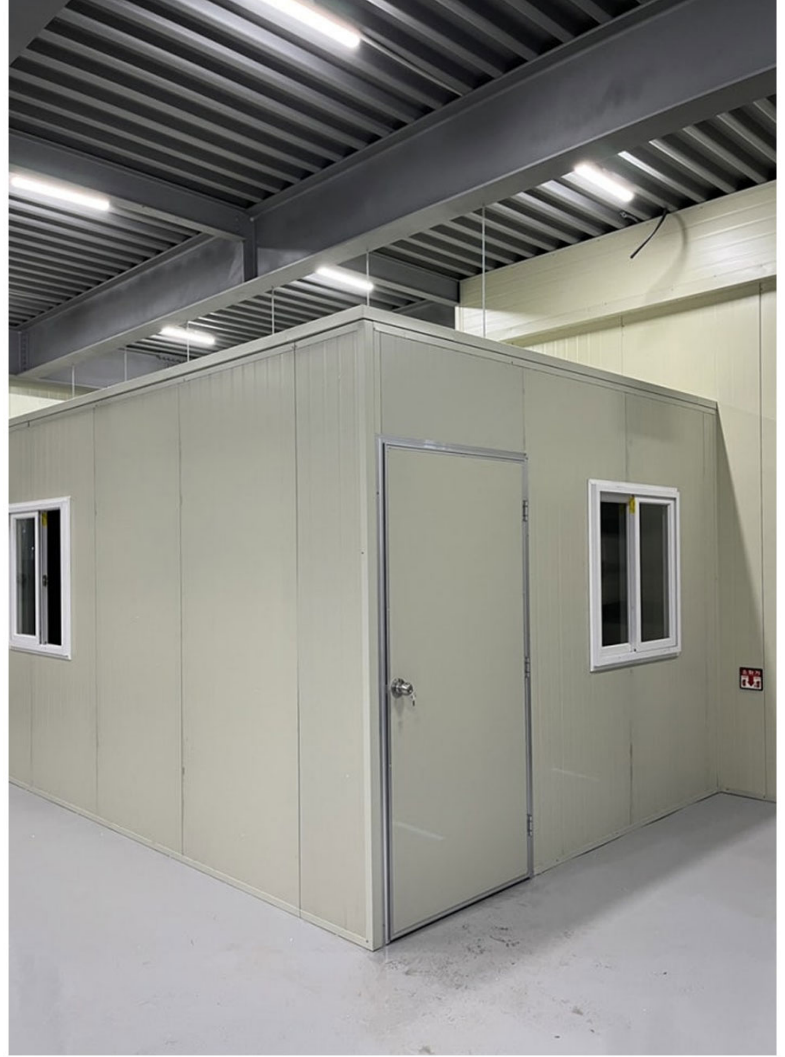
간이 사무실 공사
